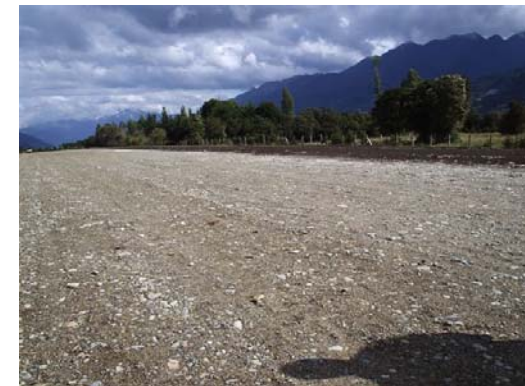
Corte y colocación de material granular en pista
